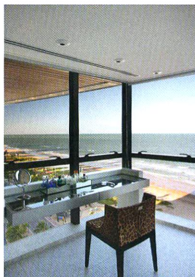
Difusores de ar lineares, com saída direcionada para o teto
