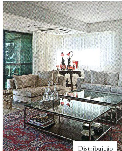
Distribuição do ar por splits do tipo cassete de quatro vias
